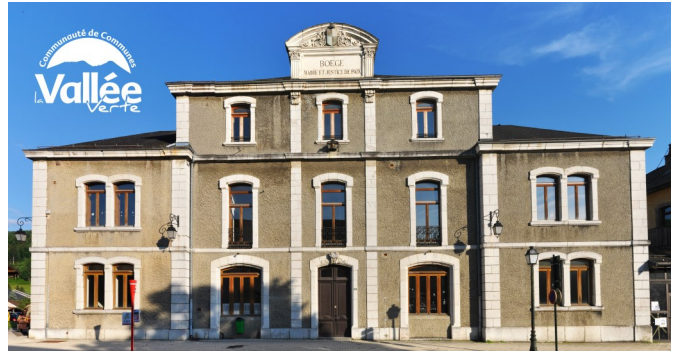
La Communauté de Communes restaure actuellement l'ancienne mairie de Boège. Les agents devraient pouvoir rejoindre les nouveaux locaux en 2018.
